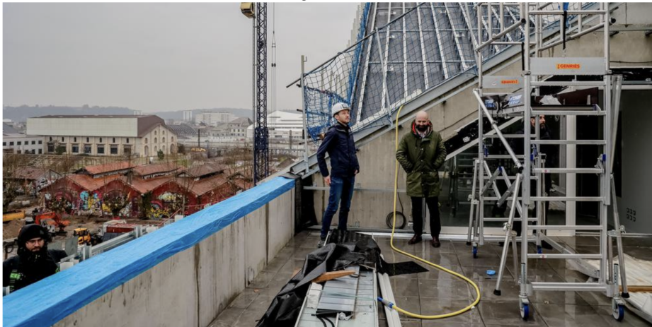
■ L'architecte Fabien Gauthier et le directeur Charles Bassi sur le chantier du campus de l'Essca, dont la livraison est attendue en mai. © Crédit photo : GUILLAUME BONNAUD / « Sud Ouest »
