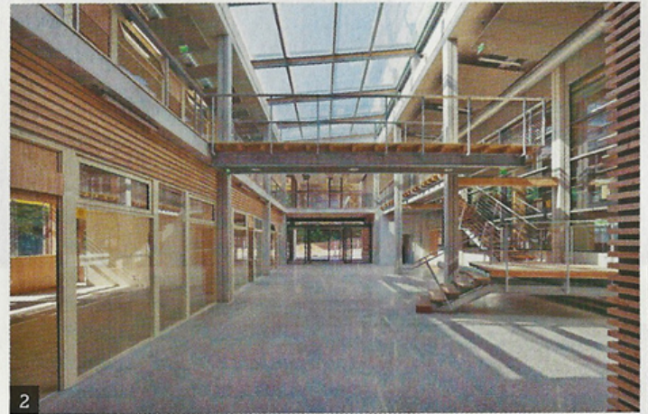
1 - Sur le campus des Landes de Juzan, à Anglet, le bâtiment accueille de jeunes entreprises innovantes.
